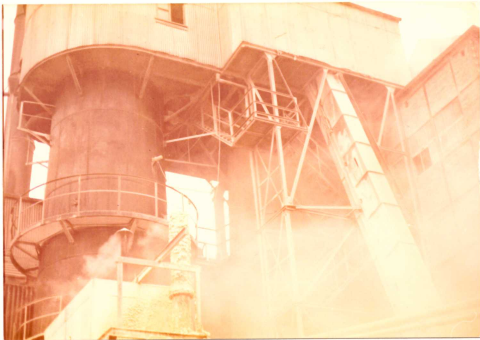
Four à chaux
